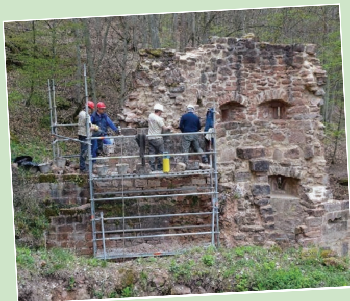
Travaux sur le mur bouclier nord
